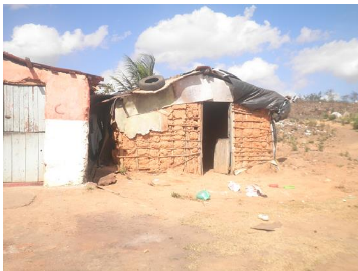
Figura 2 - Construção em taipa de mão ou pau-a-pique
