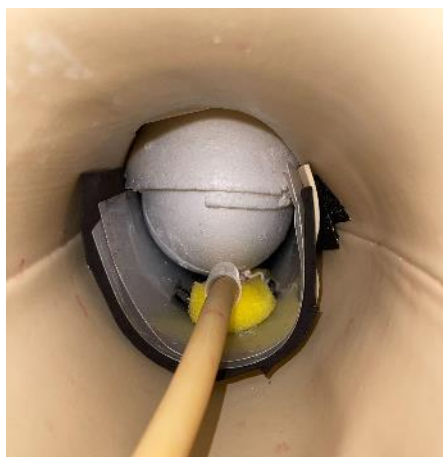
Figura 13 - Estrutura interna devidamente fixada e sustentada
